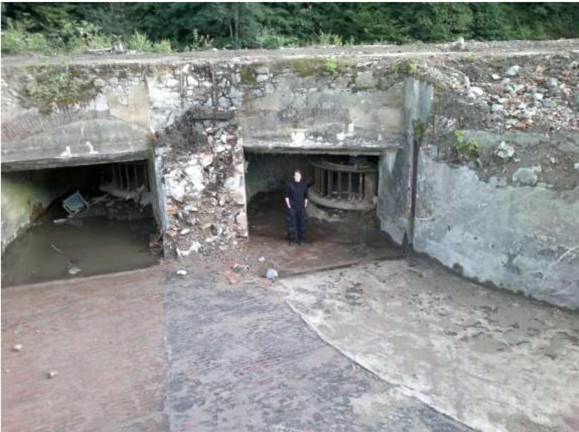
Jana Simmert an einem alten Turbinenrad. Die alte Papierfabrik „Kübler & Niethammer“ unterhalb der Burg Kriebstein wurde abgerissen. Zum Vorschein kam der alte Kanal unterhalb der Fabrik, der das Wasser der Zschopau vom Wehr zu zwei Turbinenrädern leitete und so die Energie für die Maschinen der Fabrik lieferte (Foto: H. Simmert).
